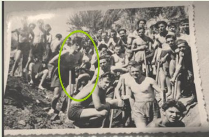
11. ábra - Csatornaépítésen - (A klott gatyás, ásóra támaszkodó legény Perics Péter)
